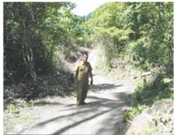
Padat karya pembangunan jalan
