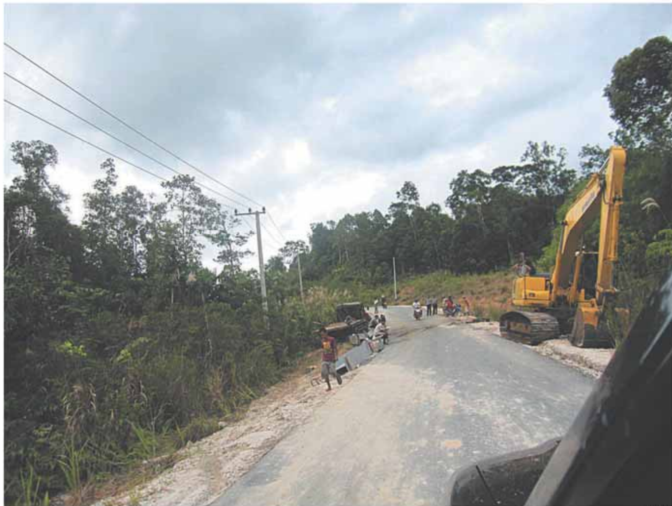
Pembangunan infrastruktur jembatan
