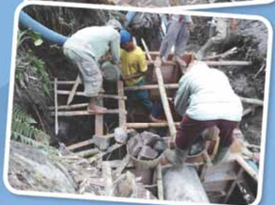
Gambar: Pelaksanaan Cash for Work dengan pekerjaan pembuatan saluran air bersih di Kecamatan Srumbung, Kabupaten Magelang, Provinsi Jawa Tengah. (foto: dokumentasi Kepala Dusun Pule, Magelang)
